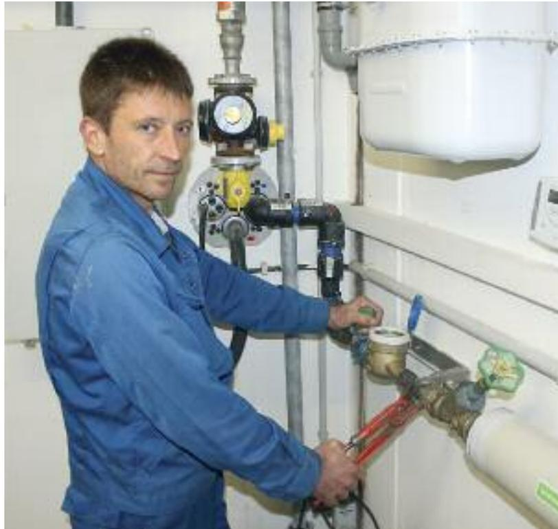
*Jeder Handgriff sitzt: Der Austausch eines alten Zählers dauert durchschnittlich nur 20 Minuten.*
