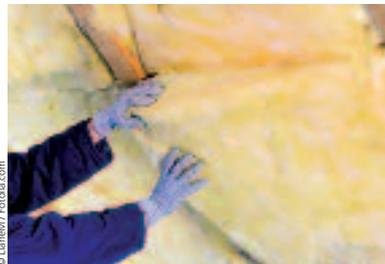
Bei einer Dachdämmung werden entweder die oberste Geschossdecke oder die Dachschrägen gedämmt.
