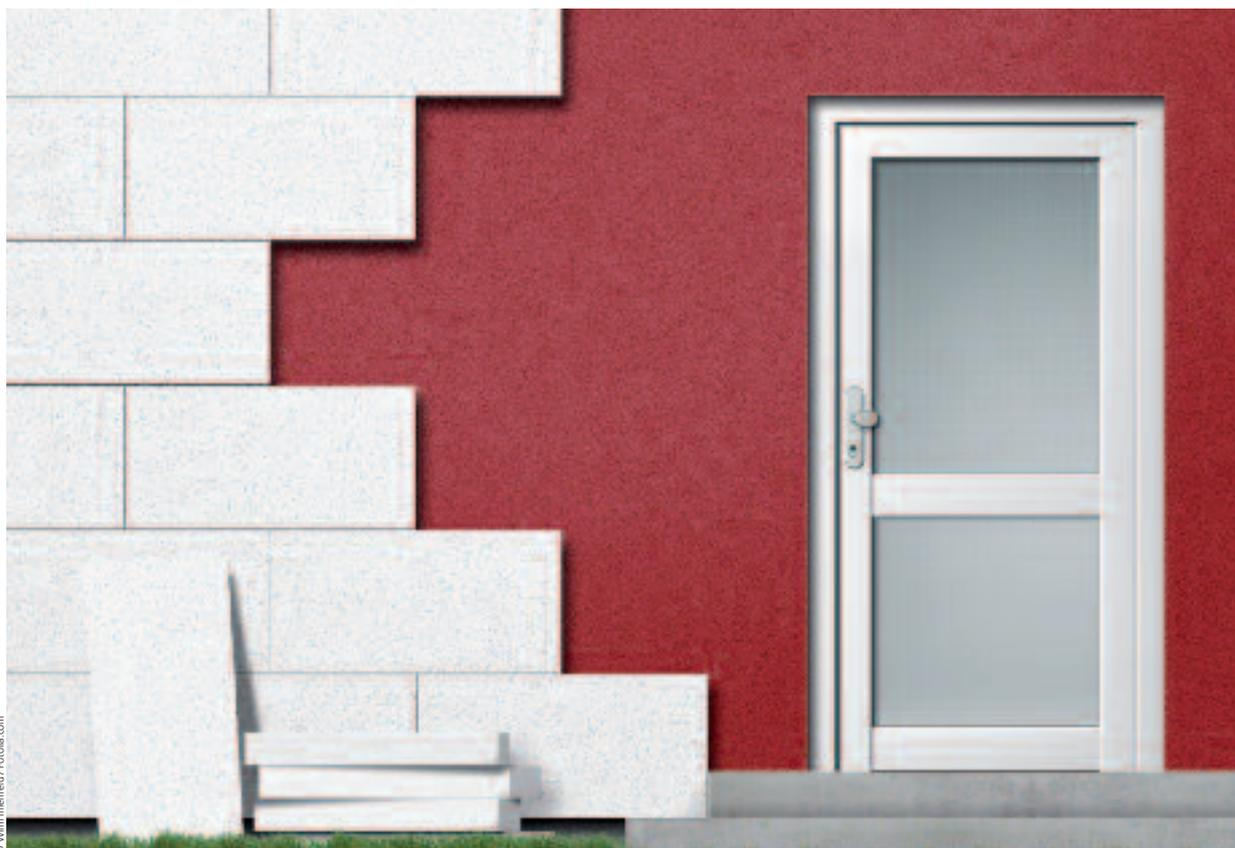
Eine Außendämmung schützt die Wände vor Witterungseinflüssen und hat eine Lebensdauer von etwa 40 Jahren.
