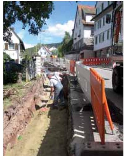
Nach dem Austausch wird die Baugrube eingesandet.
