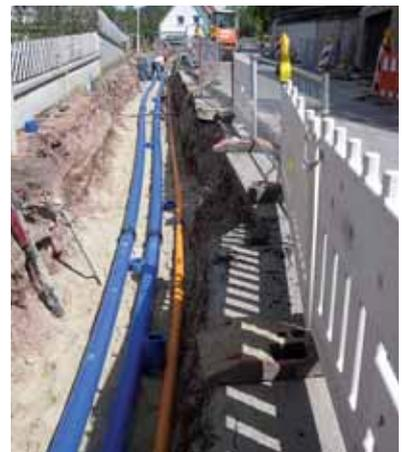
Im Bereich der Steige wurden die Versorgungsleitungen für Gas, Wasser und Strom erneuert. Aufgrund der beengten Verhältnisse war dies nicht immer einfach.
