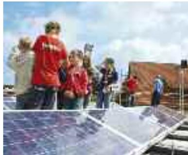
*Als das gesamte Material auf das Dach geschafft und die Unterkonstruktion aus Aluminiumstangen erstellt war, konnten die einzelnen Module montiert werden.*
