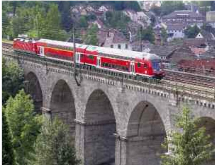
Ein eindrucksvolles Bauwerk: Der große Viadukt in Hornberg aus dem Jahr 1924. Er ist 150 Meter lang, 24 Meter hoch und besitzt sieben Bögen von je 14,5 Meter lichter Weite.
