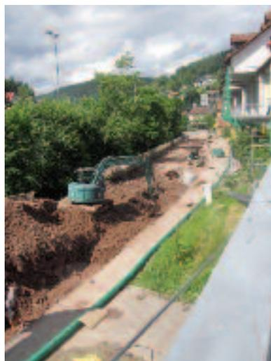
Im Zusammenhang mit dem Ausbau der Landesstraße 419 verlegen die Stadtwerke auf einer Länge von 500 Metern neue Strom-, Gas- und Wasserleitungen in der Berneckstraße. Parallel werden die entsprechenden Hausanschlüsse ausgewechselt.
