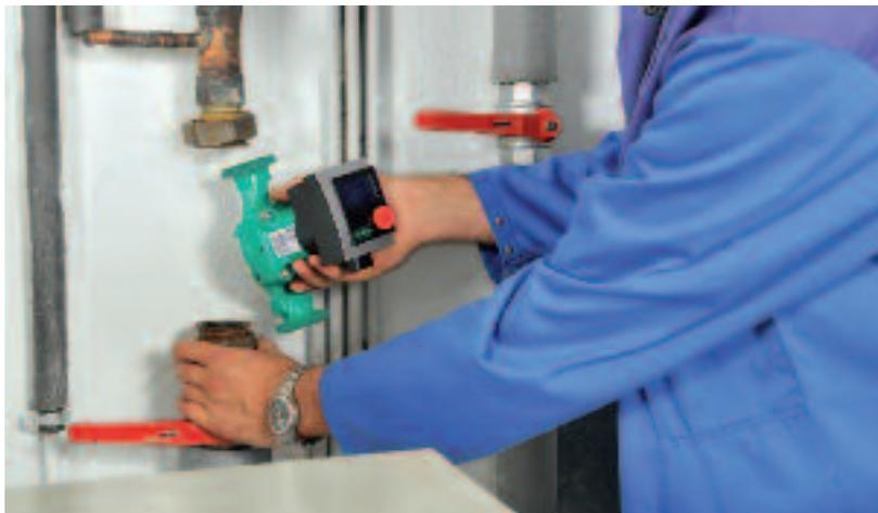
Der Einbau einer neuen Hocheffizienzpumpe lohnt sich: Verbunden mit einem hydraulischen Abgleich kann der Stromverbrauch um die Hälfte oder mehr senken.
