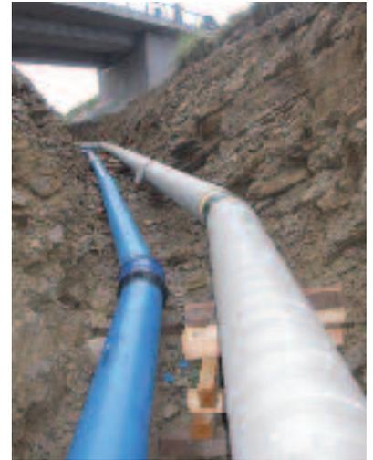
Für die neue Nordumfahrung in Dunningen muss die Gas-Hochdruckleitung an mehreren Stellen mit sehr großem Aufwand umgelegt werden.
