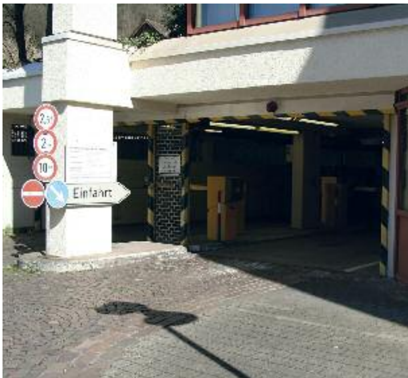
Im Parkhaus wird der Fahrbahnbelag saniert. In der Tiefgarage wird die Beleuchtung durch energiesparende LED-Technik ersetzt.
