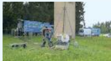
Reinigungsarbeiten am Tiefbrunnen Scheurenbauernhof.
