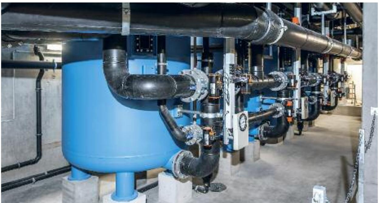
Die Wasserqualität hat oberste Priorität im „badschnass“. Auf dem Bild ist der Mehrschichtfilter für die Reinigung des Badewassers zu sehen. Nach Durchlaufen des Filters wird das Wasser wieder dem Becken zugeführt.
