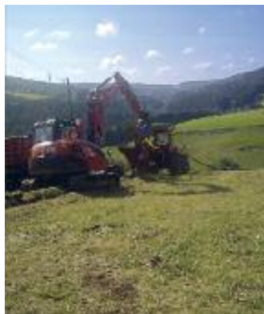
Mit Hilfe eines Kabelpflugs wurde in Tennenbronn im Bereich Unterer Schwarzenbach die 20 KV-Leitung in das Erdreich verlegt. Die Holzmasten haben ausgedient.
