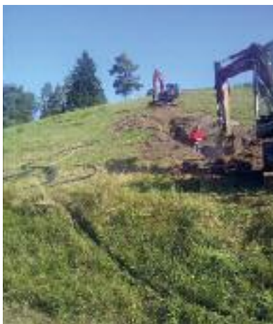
Mit Hilfe eines Kabelpflugs wurde in Tennenbronn im Bereich Unterer Schwarzenbach die 20 KV-Leitung in das Erdreich verlegt. Die Holzmasten haben ausgedient.
