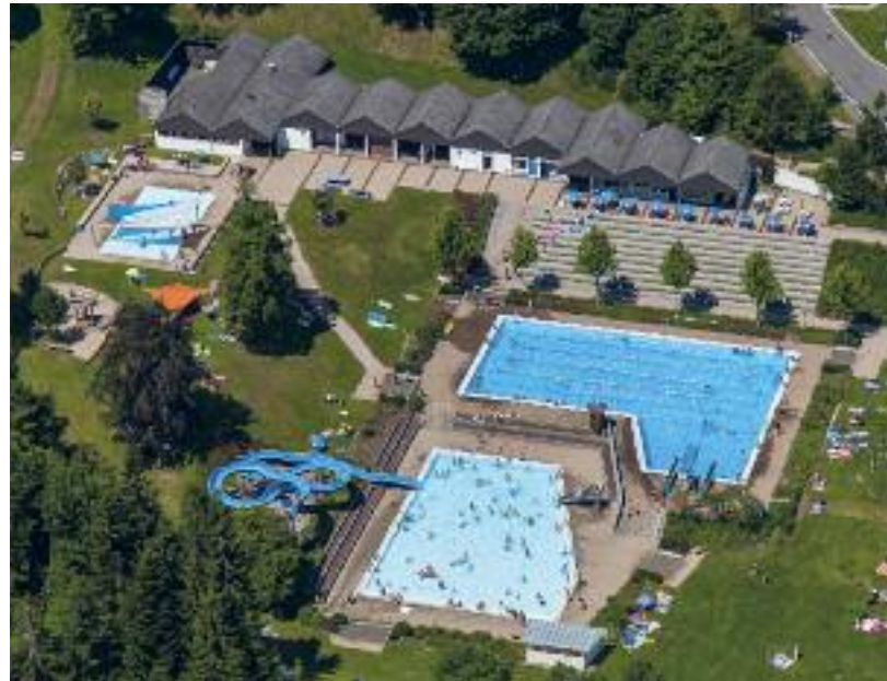
Das Tennenbronner Freibad soll 2017 grundlegend modernisiert werden.
