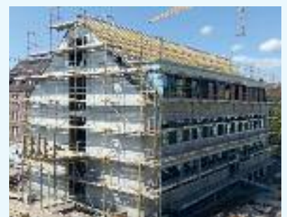
Der Rohbau des neuen Schulgebäudes ist bereits erstellt.
