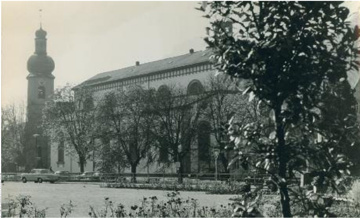
Die Glockenturm der Stadtpfarrkirche St. Maria wurde 1716 errichtet und ist heute das Wahrzeichen der Stadt.
