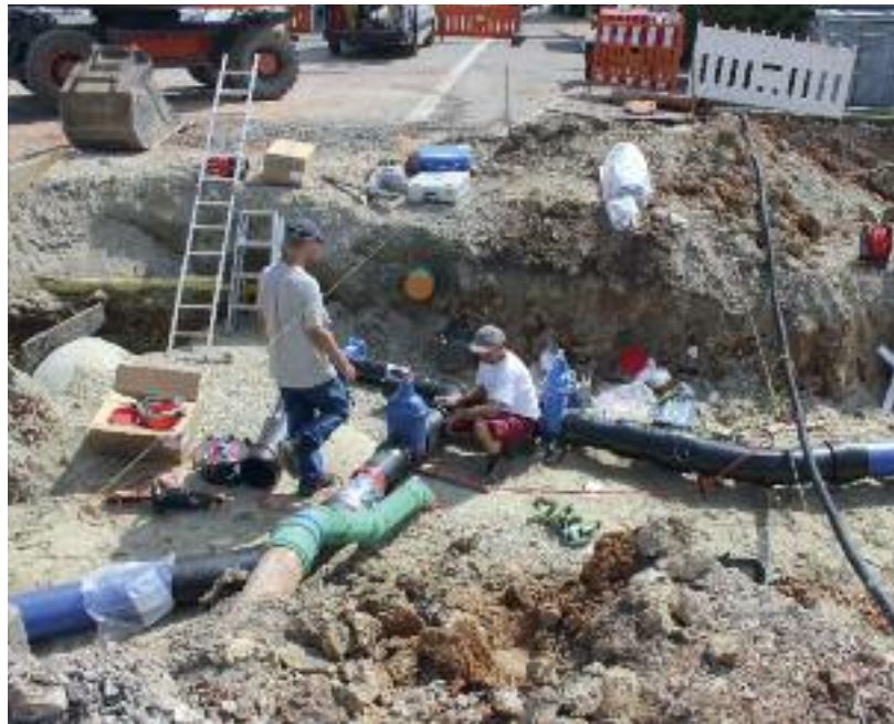
Zur Verstärkung des technischen Bereichs suchen die Stadtwerke einen Gas-/Wasserinstallateur beziehungsweise Rohrleitungsbauer.
