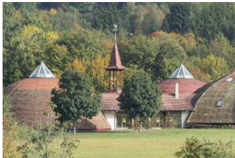
Interessant ist die „Hülle“ des Museums in Bad Dürrhein – sie besteht aus halbkugelförmigen ehemaligen Solebehältern.
