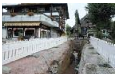
Im Stadtteil Tennenbronn haben die Stadtwerke im vergangenen Jahr in die Kanalisation beim Dorfplatz investiert.
