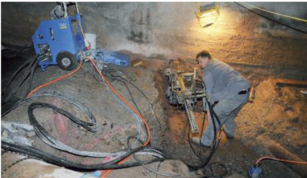
Die Stadtwerke erfüllen mit der Sanierung der Kanalisation wasserrechtliche Auflagen.
