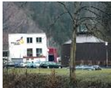
Auch optisch wurde „aufgerüstet“ und unteren anderem die Gebäude frisch gestrichen.
