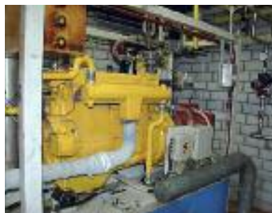
Das veraltete Blockheizkraftwerk wird durch eine moderne Anlage ersetzt.
