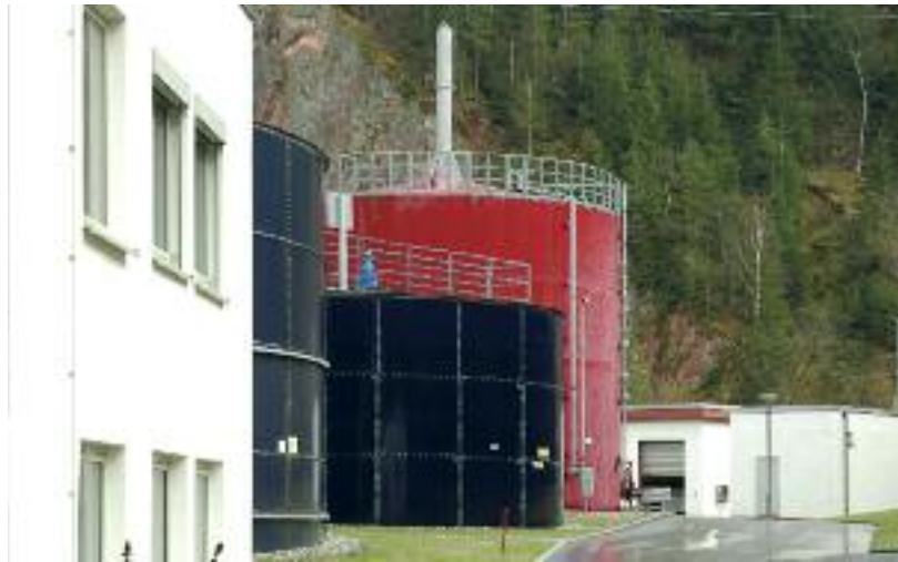
Seit vielen Jahren schon investieren die Stadtwerke konsequent in die Kläranlage.
