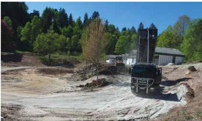
*2019: Kosten und Zeitplan kommen ins Rutschen. Nach den Erdarbeiten muss sich der Boden ein halbes Jahr setzen, bevor die Stahlbecken eingebaut werden können.*
