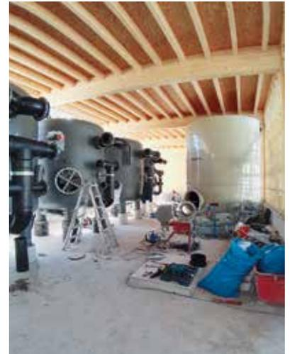
*Bädertechnik in einem neuen Gebäude: In mehreren großen Behältern mit drei Meter Durchmesser wird das Wasser für die verschiedenen Becken aufbereitet.*
